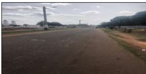
Photo 1 : Aperçu d'une voie en bon état
