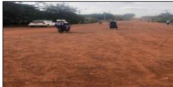
Photo 2 : Aperçu d'une voie non bitumée
