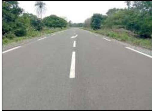
Photo i : Route départementale 14.1.00 dans la commune de Santhiaba Manjaque (Sources : Auteurs, juillet 2024)
