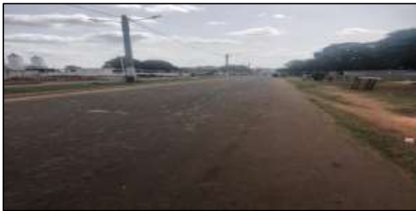
Photo 1 : Aperçu d'une voie en bon état
