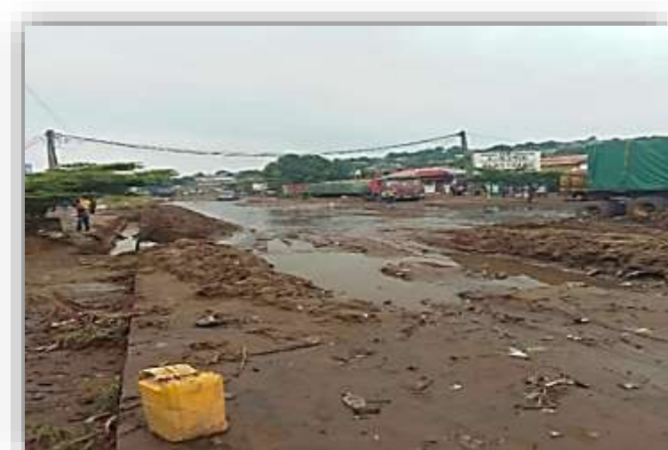
Photo 2 : Ensablement et inondation de la route Maman Mboulé - Manianga, à l'arrêt la ferme, à Manianga après une forte pluie
