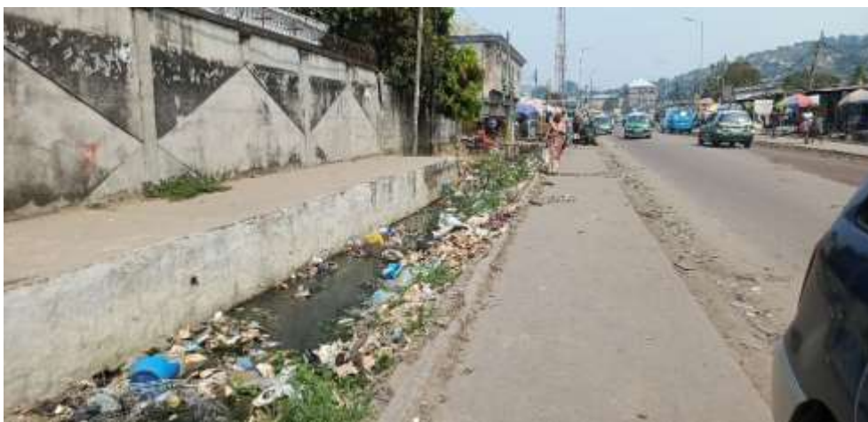
Photo 4 : Canalisation d'eau bouchée par les déchets à Ngamakosso
