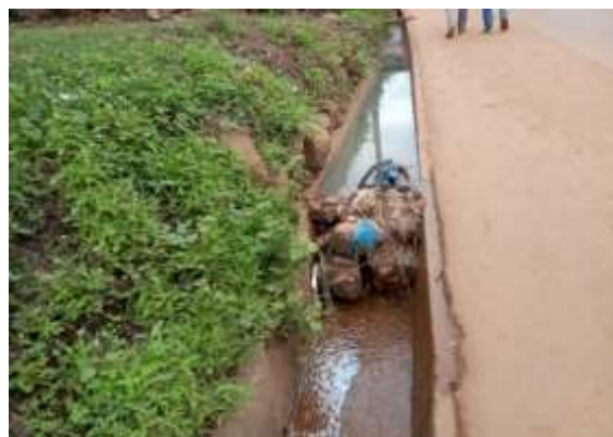
Photo B : Caniveau volontairement obstrué pour recueillir du sable à Grand Gbapleu
