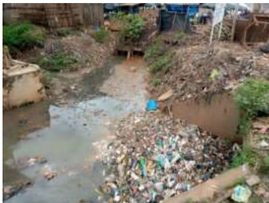
Photo A : Canaux d'évacuation des eaux bouchés au quartier Koko non loin du marché (Prise de vue : Koné Alain ; Août 2020)
