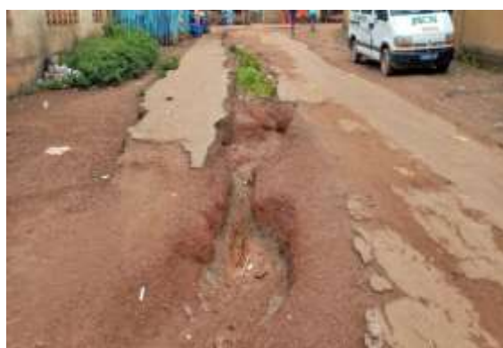
Photo B : Voie dégradée par l'érosion à Treize (Prises de vues : Koné Alain ; Août 2020)
