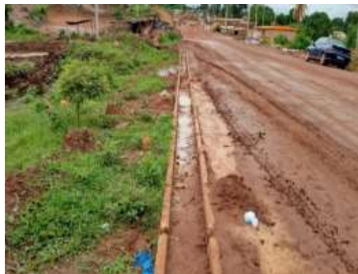
Photo B : Caniveau rempli de boue au quartier Camp Séa (Prise de vue : Koné Alain ; Août 2020)
