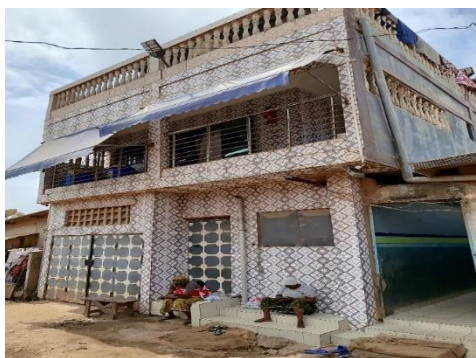
Photo 3 : Vue d'un bâtiment en hauteur dans le quartier Vridi 3
